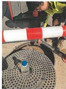
站内地下水井
