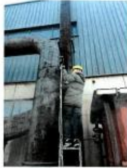
DA001 生物质锅炉废气排气筒出口
